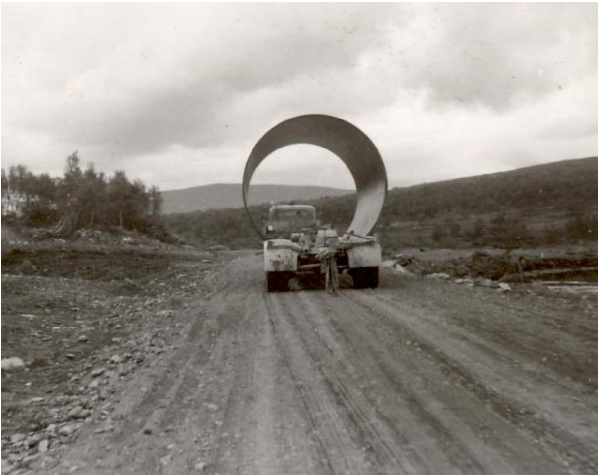
Transport av trykkrør til Nea kraftverk ↑ ↓
