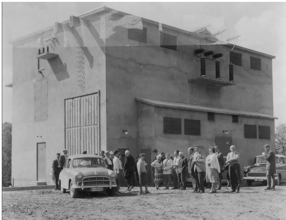
Befaring ved Reitan trafostasjon juni 1961
