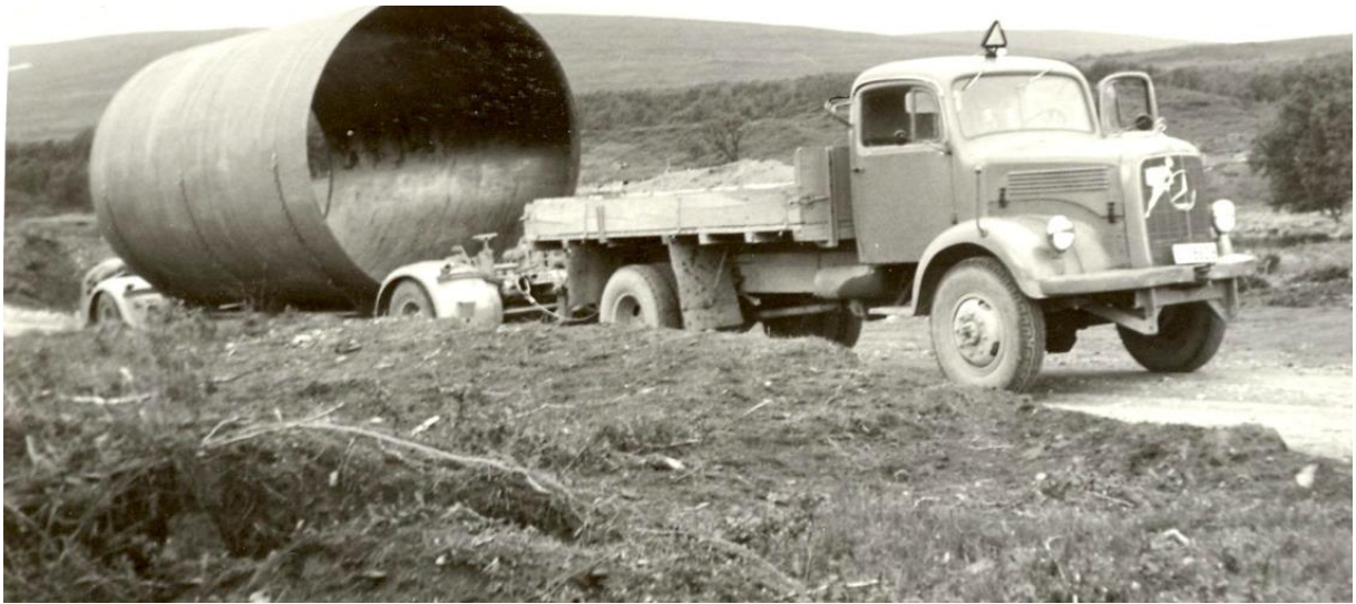
Transport av trykkrør til Nea kraftverk ↑ ↓
